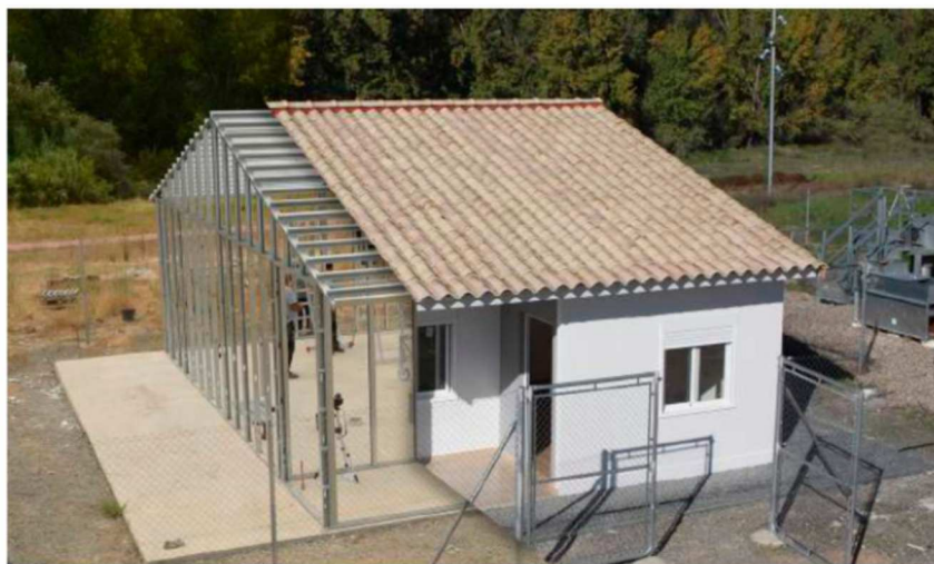
Construcción de vivienda con sistema EcoFrame
