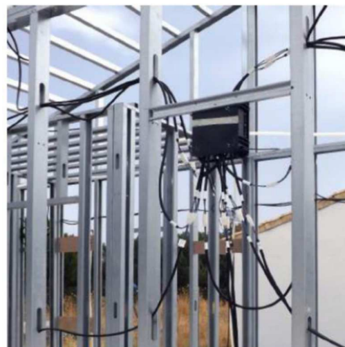
Kit pre-montado de instalaciones eléctricas con conexiones rápidas.
